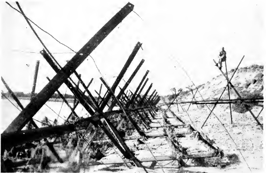
Fig. 7—Type B steel jetty units.
